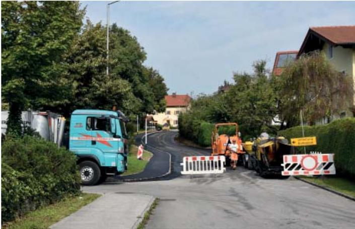
In der Jakobstraße zwischen Rupertstraße und dem Gewerbegebiet wurde der Lückenschluss im Gehweg mit Beleuchtung fertiggestellt und die Wasserleitung zu einem Ringsystem zusammengeschlossen. Weiters wurde in diesem Abschnitt auch die Fahrbahn saniert.
